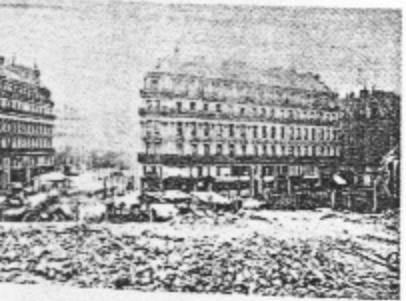
Demolición de Les buttes des Capucins para la apertura de la avenida de la Ópera, Paris, 1877.
