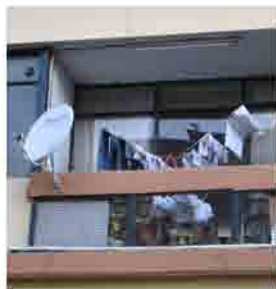
Balcon utilizado para colgar ropa, tambien se instalan antenas de television.
