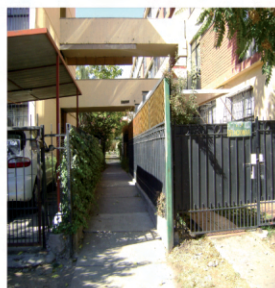
Ocupacion del espacio como proteccion por el cerramiento y por necesidad debido al auto dejando un pasillo de circulacion.
